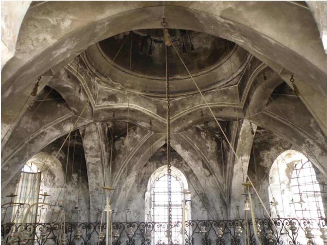
SULLA CALOTTA DELLA CUPÉOLA SI PUÒ OSSERVARE IL GENERALIZZATO DEGRADO DOVUTO ALLA UMIDITÀ CHE SI MANIFESTA SOTTOFORMA DI MACCHIE NERE ED INFLORESCENZE .
