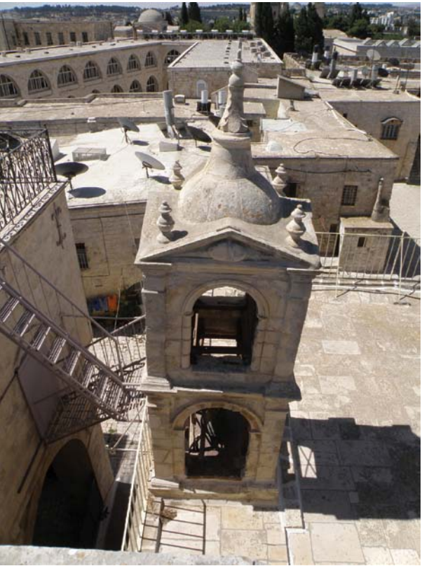
LA TORRE CAMPANARIA, POSTA IN CORRISPONDENZA DELLA FACCIATA SUD, PRESENTA UNA STRUTTURA DI PILASTRI ANGOLARI IN PIETRA E UNA COPERTURA ANCH'ESSA IN PIETRA. A CAUSA DELL'IMPORTANTE SPOSTAMENTO FUORI PIANO CHE SI È DETERMINATO, LA STRUTTURA NON VIENE PIÙ USATA.
