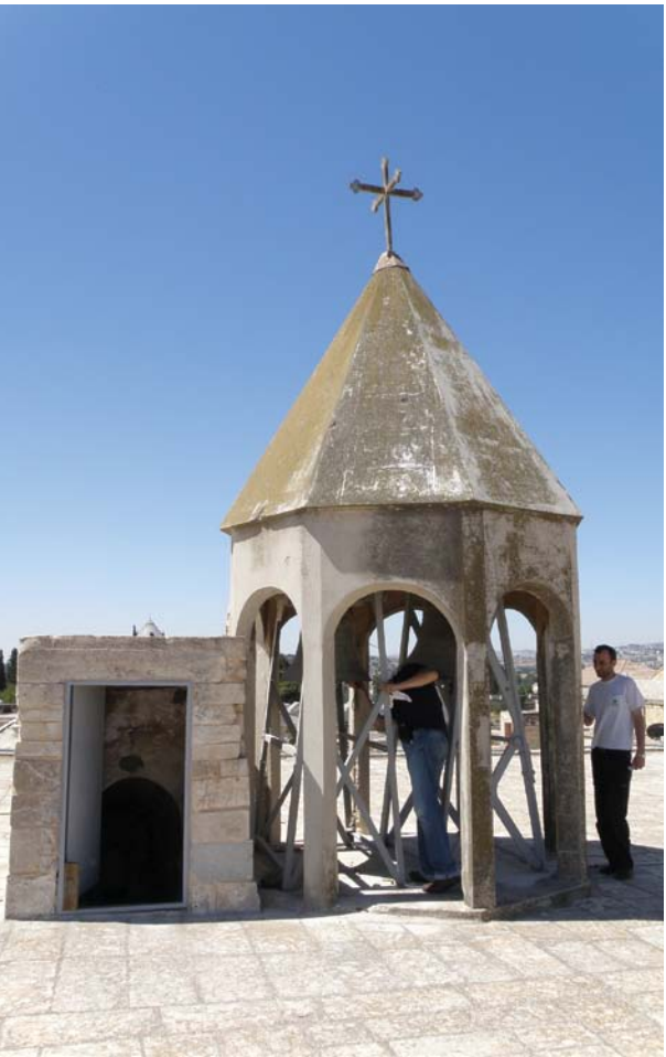
LA NUOVA TORRE CAMPANARIA È STATA REALIZZATA CON UNA STRUTTURA A BASE ESAGONALE IN CEMENTO ARMATO. LA COPERTURA È ANCH'ESSA IN CEMENTO ARMATO, CON FORMA PIRAMIDALE, SOVRASTATA DA UNA CROCE IN METALLO. ALL'INTERNO UNA STRUTTURA METALLICA SORREGGE LE CAMPANE.
