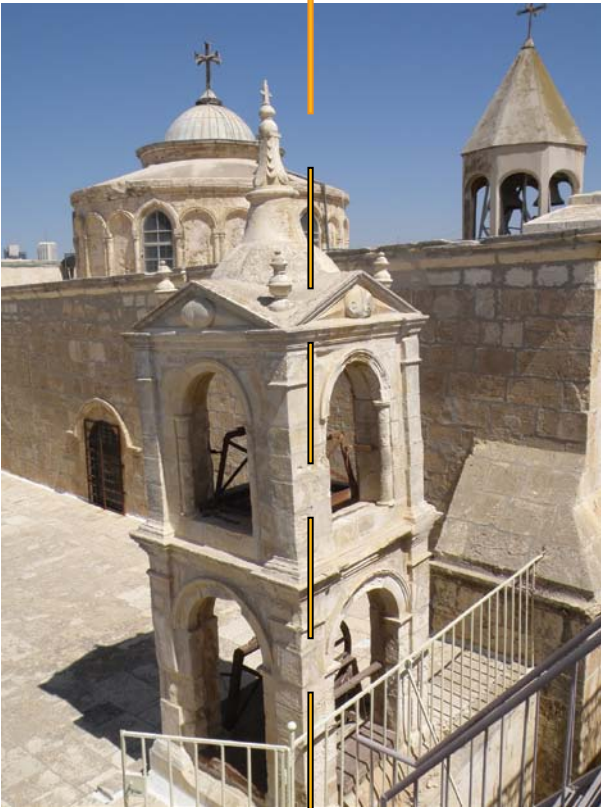
LA TORRE CAMPANARIA, POSTA IN CORRISPONDENZA DELLA FACCIATA SUD, PRESENTA UNA STRUTTURA DI PILASTRI ANGOLARI IN PIETRA E UNA COPERTURA ANCH'ESSA IN PIETRA. A CAUSA DELL'IMPORTANTE SPOSTAMENTO FUORI PIANO CHE SI È DETERMINATO, LA STRUTTURA NON VIENE PIÙ USATA.
