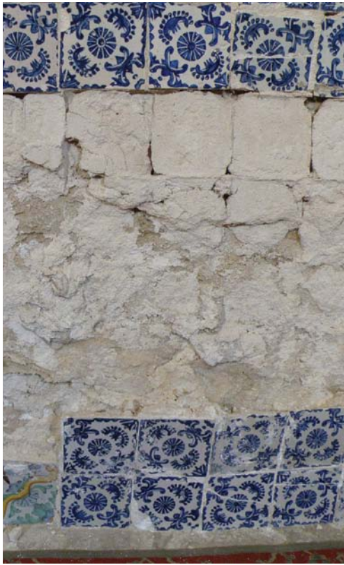
L'UMIDITÀ HA DETERMINATO IL DEGRADO, ED IN ALCUNI CASI LA PERDITA, DELLE MAIOLICHE DI RIVESTIMENTO DELLE PARETI.
