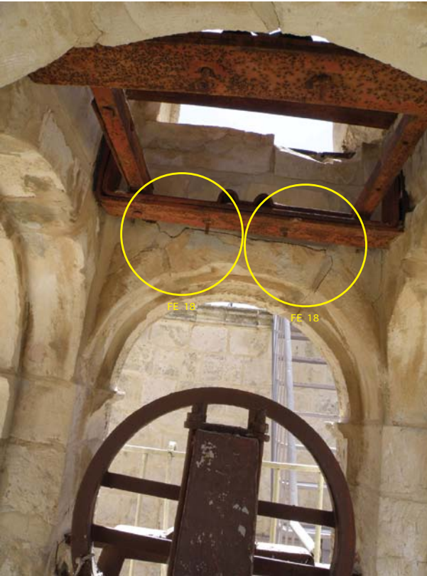
FE 16 FESSURA ORIZZONTALE DEL PILASTRO. FE 17, FE 18, FE 19 FESSURE CHE INTERESSANO GLI ARCHI DEL PRIMO LIVELLO DELLA TORRE CAMPANARIA. SI SVILUPPANO TRASVERSALMENTE E ORIZZONTALMENTE SEGUENDO I LETTI DI POSA DELLE PIETRE.
