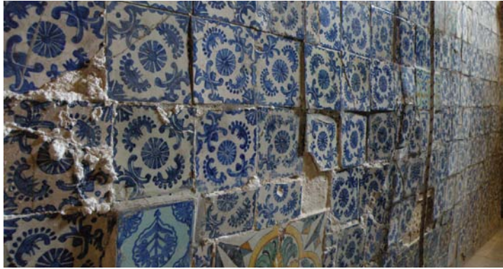
L'UMIDITÀ HA DETERMINATO IL DEGRADO, ED IN ALCUNI CASI LA PERDITA, DELLE MAIOLICHE DI RIVESTIMENTO DELLE PARETI.
