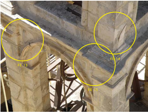
FE 13 LA FESSURA SI SVILUPPA A PARTIRE DAL PILASTRO ANGOLARE E PROSEGUE TRA I CONCI DELL'ARCO INFERIORE SINO AD INTERCETTARE LA FESSURA FE 15. LA LESIONE RISULTA RIPRESA CON MALTA.
