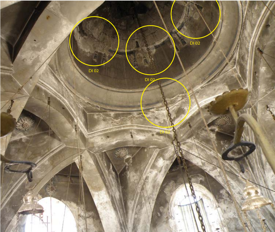
DI 02 SI OSSERVA ANCHE IL DISTACCO DI ALCUNI STUCCHI NELLA DECORAZIONE DELLA CALOTTA DELLA CUPOLA.
