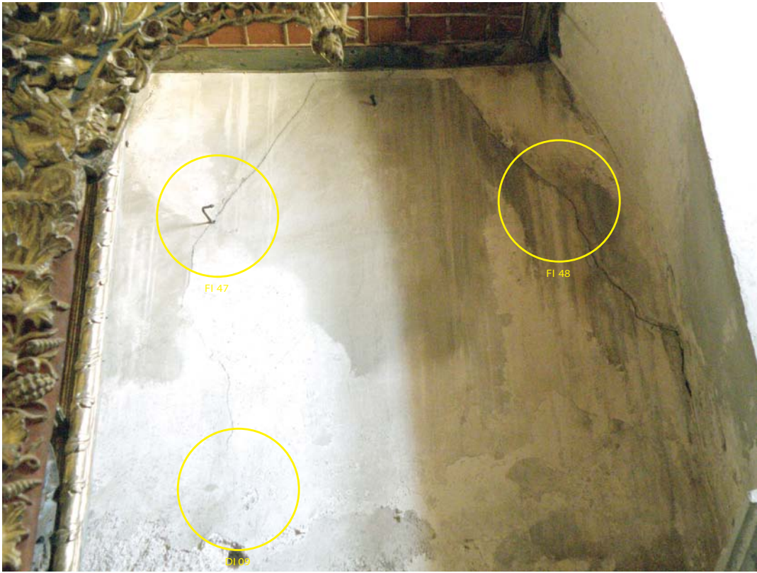
FESSURE FI 47 ED FI 48 SI SVILUPPANO SULLA MURATURA. FORTI SEGNI DI DEGRADO, DI 09, CORRELATI ALLA UMIDITÀ.
