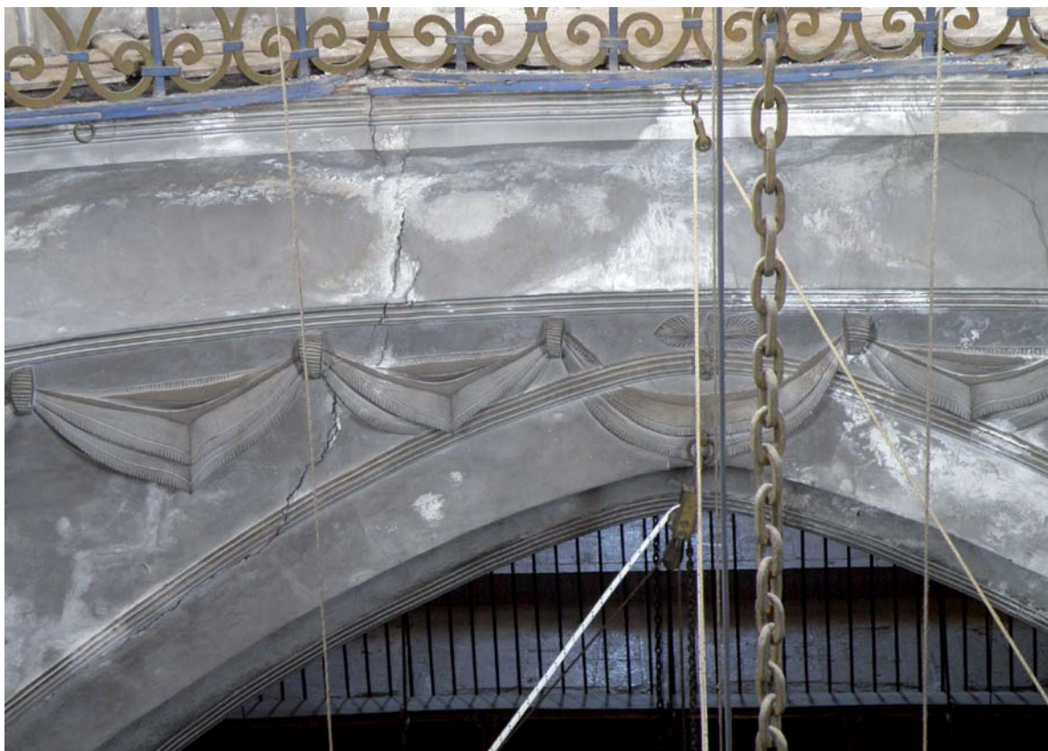
Fessure arco principale sotto la cupola lato ovest (verso l'ingresso principale) – altra vista
