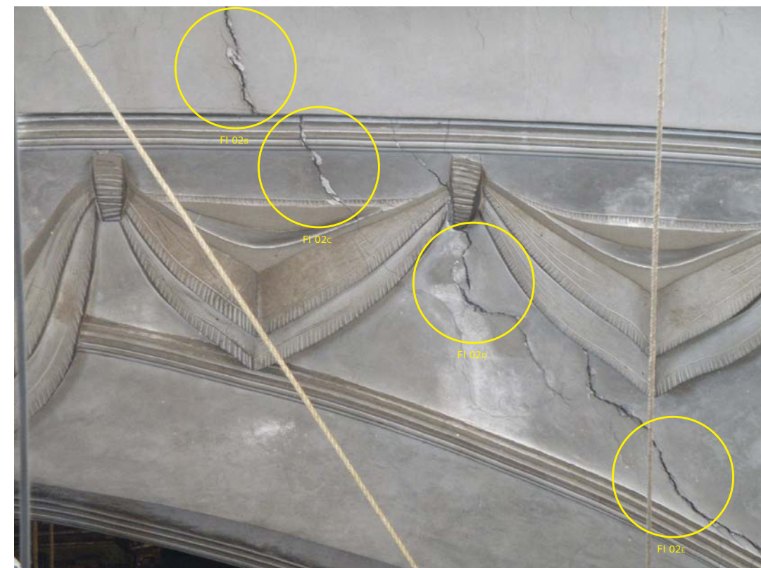
LA FESSURA FI 02 SI SVILUPPA A PIÙ RIPRESE (FI 02 A, FI 02 B, FI 02 C, FI 02 D, FI 02 E) SECONDO UNA LINEA DIAGONALE CHE, A PARTIRE DAL CORNICIONE DELLA BALAUSTR A , PROSEGUONO VERSO L'APPOGGIO DI DESTRA DELL'ARCO .
