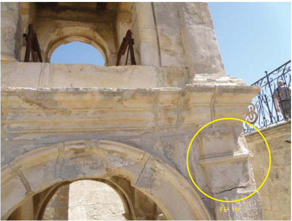
LA TORRE CAMPANARIA, POSTA IN CORRISPONDENZA DELLA FACCIATA SUD, PRESENTA UNA STRUTTURA DI PILASTRI ANGOLARI IN PIETRA E UNA COPERTURA ANCH'ESSA IN PIETRA. A CAUSA DELL'IMPORTANTE SPOSTAMENTO FUORI PIANO CHE SI È DETERMINATO, LA STRUTTURA NON VIENE PIÙ USATA.
